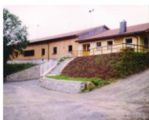
Stockschießhalle mit drei Bahnen (Beton) und Vereinsheim des EC Kronberg Bodenmais von 1964 e.V.
